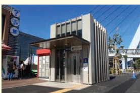
東京テレポート駅 改札外エレベーター増設
