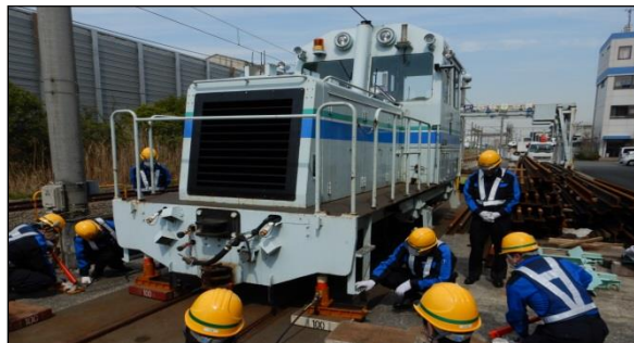
【保守用車脱線復旧訓練】
