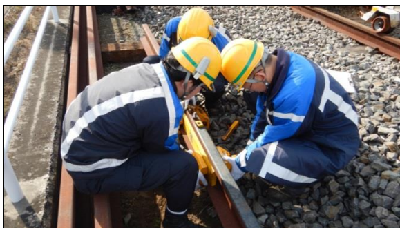
【レール折損対応訓練】
