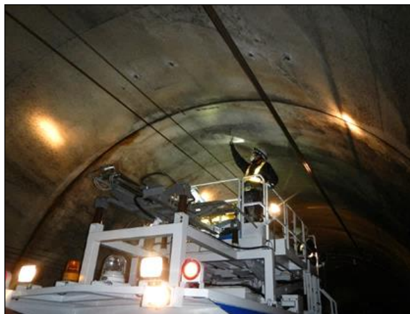
【高所作業車による点検】
