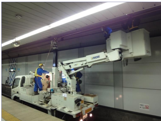
【トロリー線の張替】
