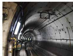
トンネル照明更新
