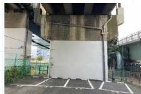
高架橋耐震補強
