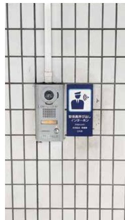
駅係員呼び出しインターホン
