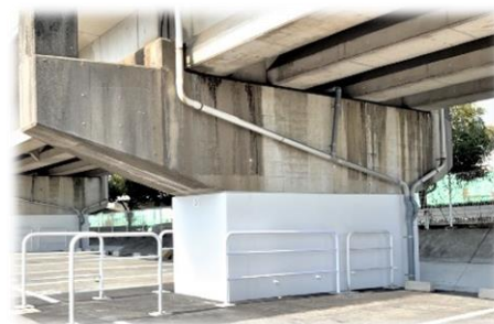
鉄道高架橋の橋脚耐震補強
