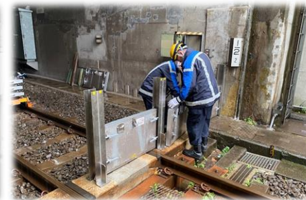
止水板設置訓練
