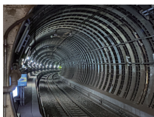
トンネル照明更新
