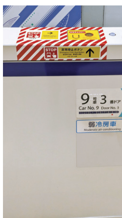
列車非常停止ボタン(ホームドア)
