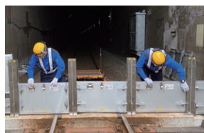
保守係員教育（止水板設置訓練）
