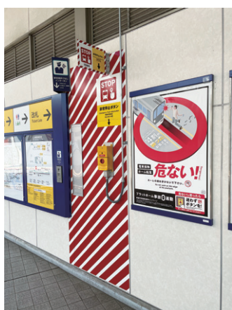
列車非常停止ボタン
