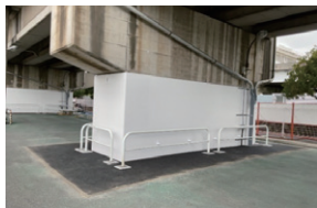
高架橋耐震補強
