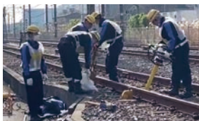
線路陥没復旧
