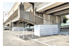
高架橋耐震補強
