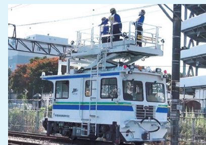
架線復旧訓練
