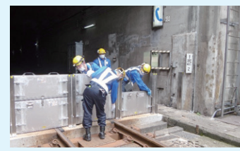
保守係員教育(止水板設置訓練)
