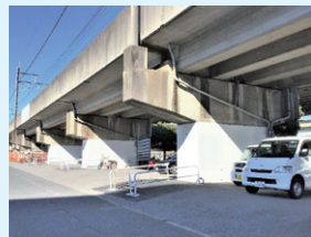
高架橋耐震補強
