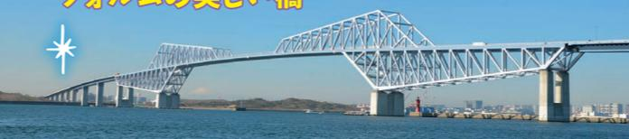
橋の形が特徴的なのは飛行機や船舶の航行の安全を確保したため
