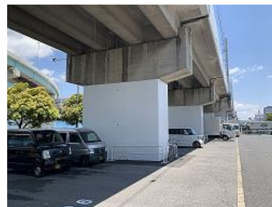
高架橋の耐震補強
