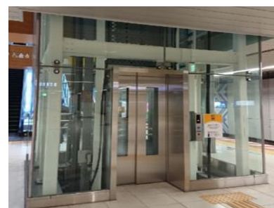
エレベーター増設 (東京テレポート駅)
