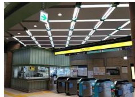
駅照明のLED化
