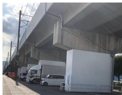
高架橋の耐震補強
