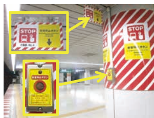
列車非常停止ボタン
