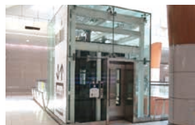
東京テレポート駅改札内エレベーター増設
