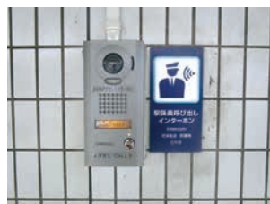
駅係員呼び出しインターホン
