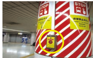
列車非常停止ボタン
