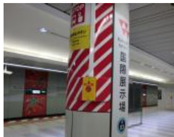
【非常停止ボタン】
