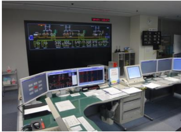
【電力管理システム】
