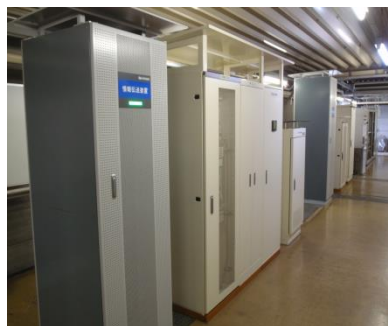
写真左から、「放送設備及びITV監視設備」「情報伝送設備」「情報サーバー設備」
