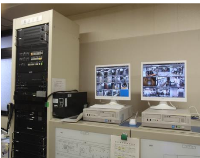
写真左から、「放送設備及びITV監視設備」「情報伝送設備」「情報サーバー設備」
